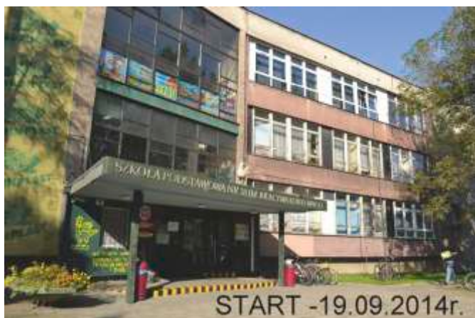
Fot. 1. Budynek szkoły przed rozpoczęciem remontu
