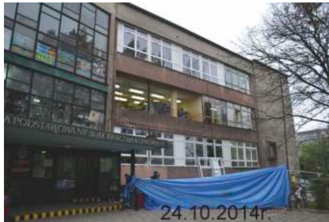
Fot. 2. Rozpoczęcie prac remontowych
