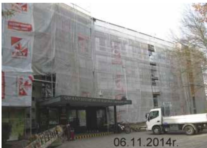
Fot. 3. Budynek szkoły w trakcie remontu
