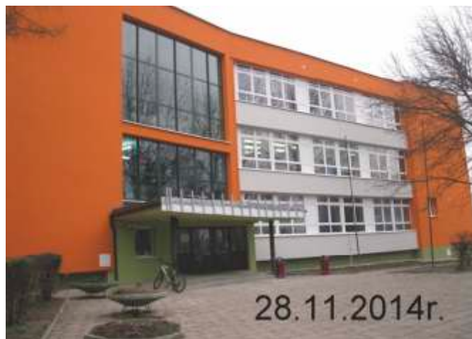
Fot. 4. Budynek szkoły po remoncie
