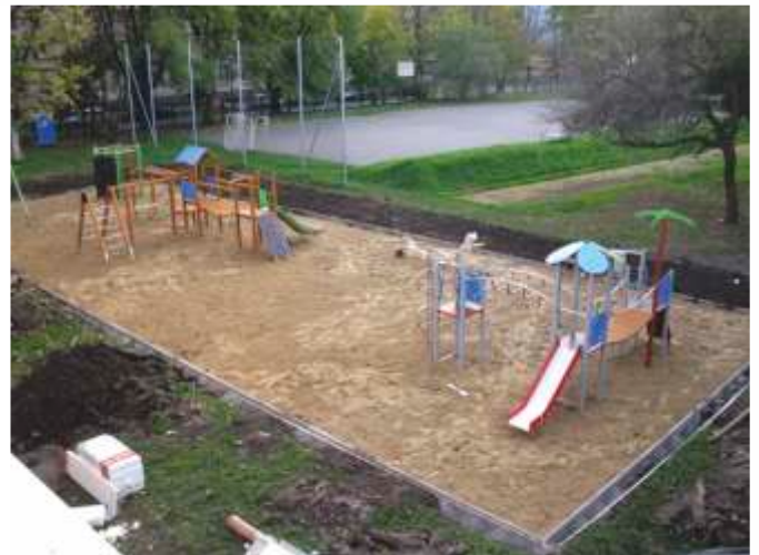
Fot. 6. Plac zabaw w trakcie prac
