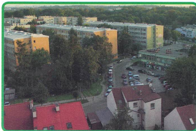
Zabudowa mieszkaniowa w obrębie Starego Dąbia
