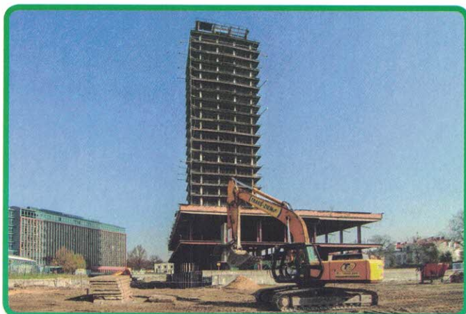
Budowa „Unity Tower”
