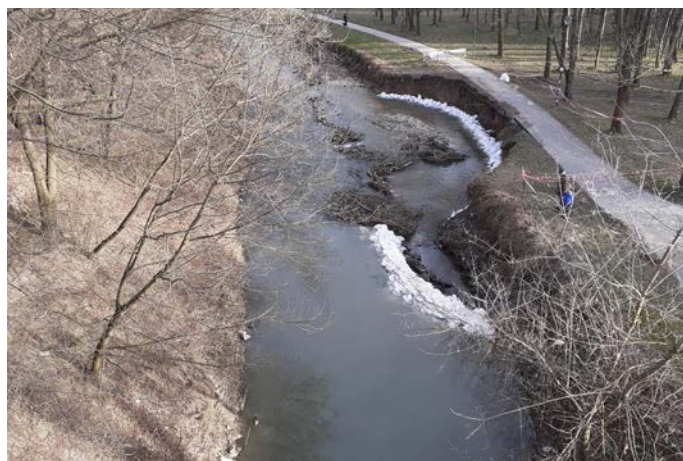
wyrwa na rzece Białucha- widok od strony Al. Pokoju
